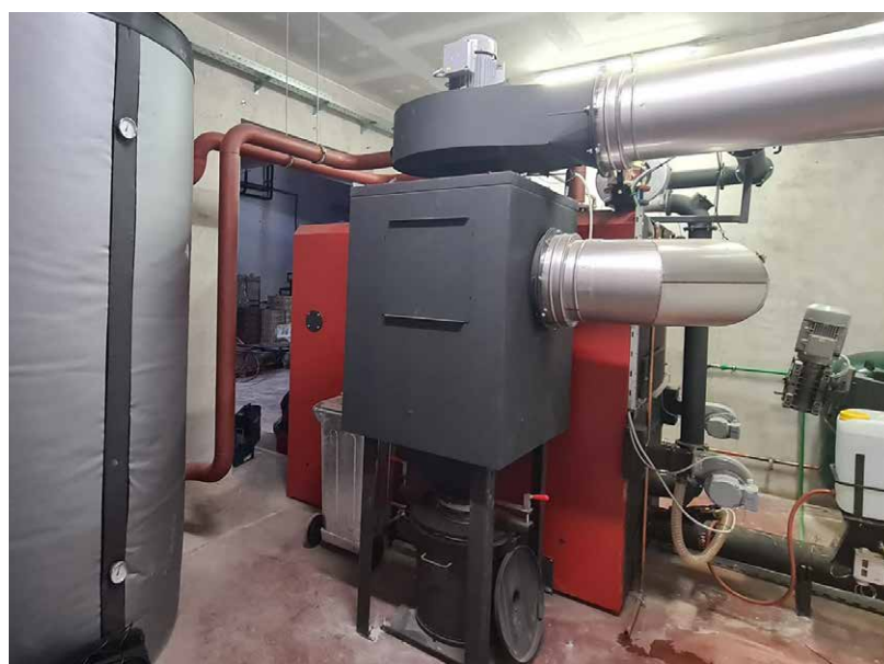
□ Kotlovnica s kotlom Nolting LCS-RU 400/450 kW u tvornici Ferrotehna, Otočac, Hrvatska
