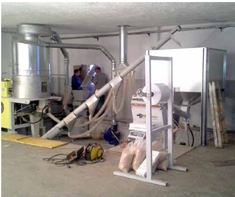
□ Linija za proizvodnjo peletov P SYSTEM P 300 med montažo pri stranki EXTRAFORM v Prestranku, Slovenija
